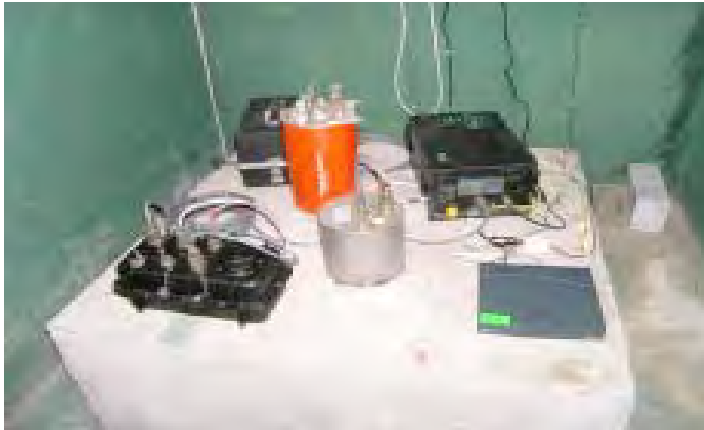
Фиг. 2. Част от сеизмичното оборудване на НОТССИ Fig. 2. Part of the seismic equipment of NOTSSI
